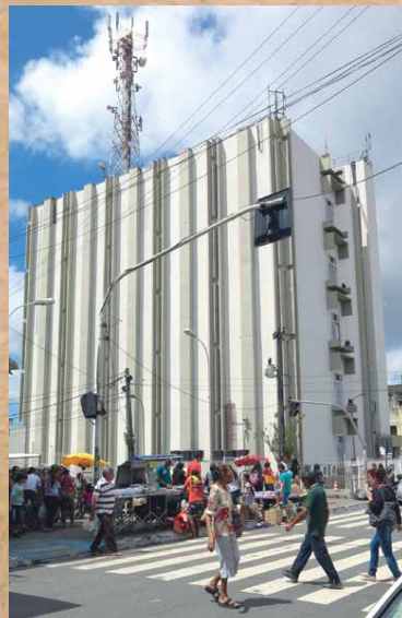
Prédio está localizado no Centro comercial da capital
