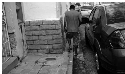
Muitas ruas de Campina Grande são invadidas por muros e paredes, impedindo que o pedestre transite pelas calçadas
